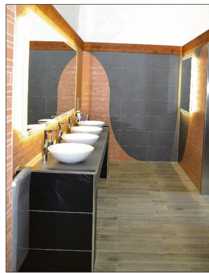
1A: Die Sanitäranlage der Mehrzweckhalle.
